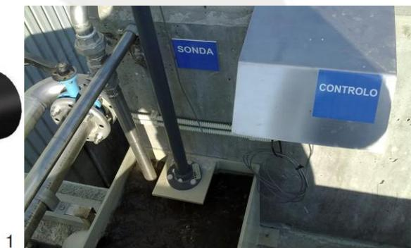
Se o valor de redox medido no tanque de dessulfuração for  $<-100$  então não é certo que todo o processo de passagem de sulfuretos a sulfatos tenha ocorrido.
