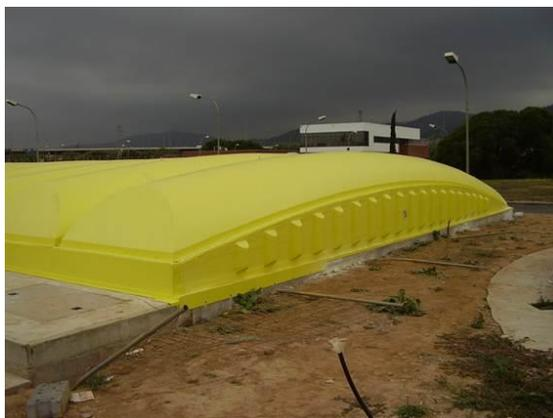
Como referido, também deverá ser implementado um sistema de recolha e tratamento dos gases gerados na dessulfuração. Dos contactos desenvolvidos com potenciais fornecedores, existem também diferentes soluções que terão de ser dimensionadas e adaptadas a cada caso, pois estas têm características técnicas e gamas de aplicação diferentes. No entanto, face ao conhecimento existente e à tipologia dos gases a tratar, é mais indicada a desodorização por lavagem química.
